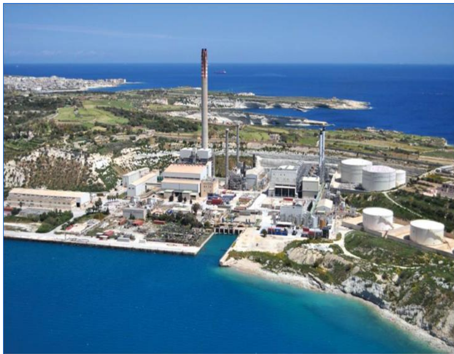
上海电力马耳他D3电厂
